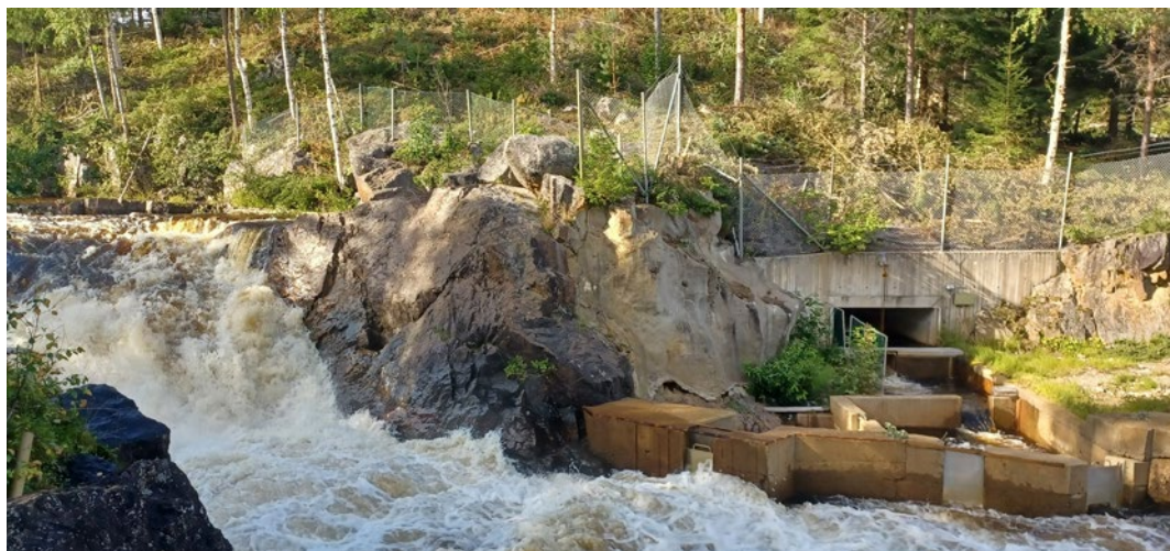
Lögdeälven, laxtunnel i Fällfors. Foto: Martin Engström.
