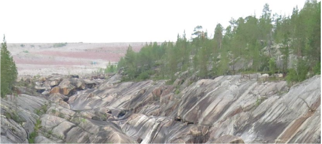
Harsprånget i Luleälven, damm och nedströms torrflå. Foto: Martin Engström.
