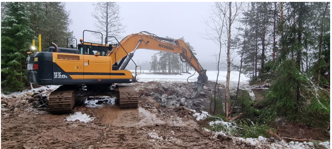
Utrivning av dammen in Holmsjön. Foto: Mikael Rhönstad.
