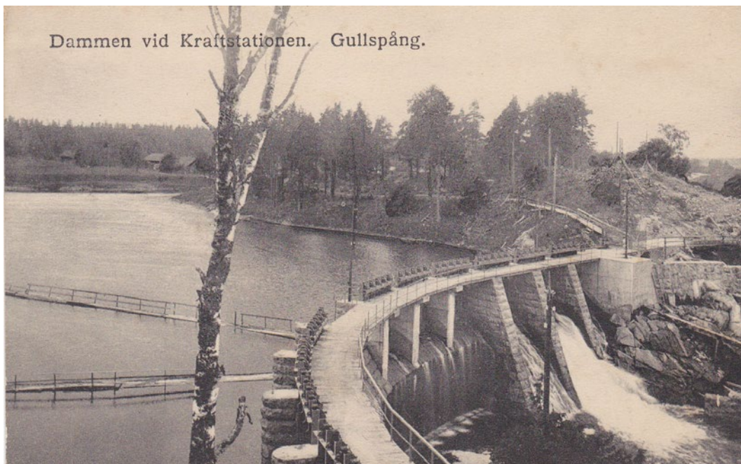
Dammen vid kraftstationen i Gullspång årtal okänd. Fotograf: Okänd, källa Amnehärads hembygdsförening.
